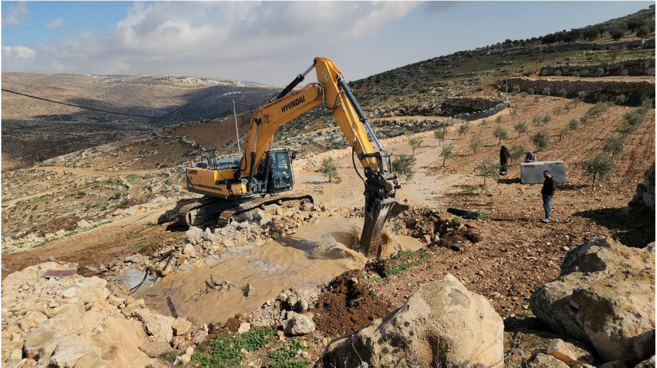
Demolizione di una cisterna per l'acqua piovana ad al-Buweib, nelle colline a sud di Hebron. Foto di Nasser Nawaj'ah, B'Tselem, 12 febbraio 2023.
